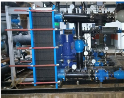
供热水水换热机组温度节能控制
